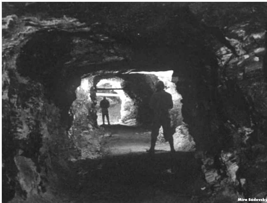
„Hlavní chodba“ původně vedla k Nové jámě. Na jejím konci se místo náraziště nachází jen vysypaný kužel materiálu ze zásypu šachty.
